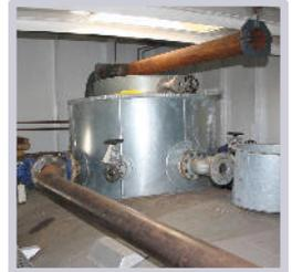
Dampfdom mit Anschlüssen
